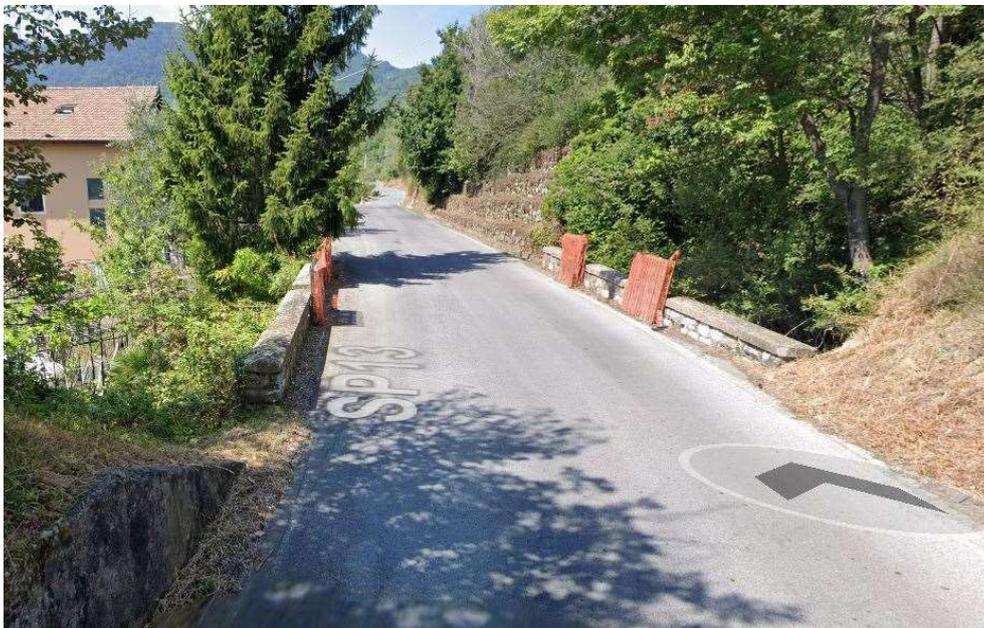
Nel ponte al km. 12+709 sono costituite da muretti in calcestruzzo ormai deteriorati e degradati, non in regola neppure per il transito pedonale inoltre mancano del tutto le barriere in adiacenza la ponte come visibile dalla fotografia allegata.
