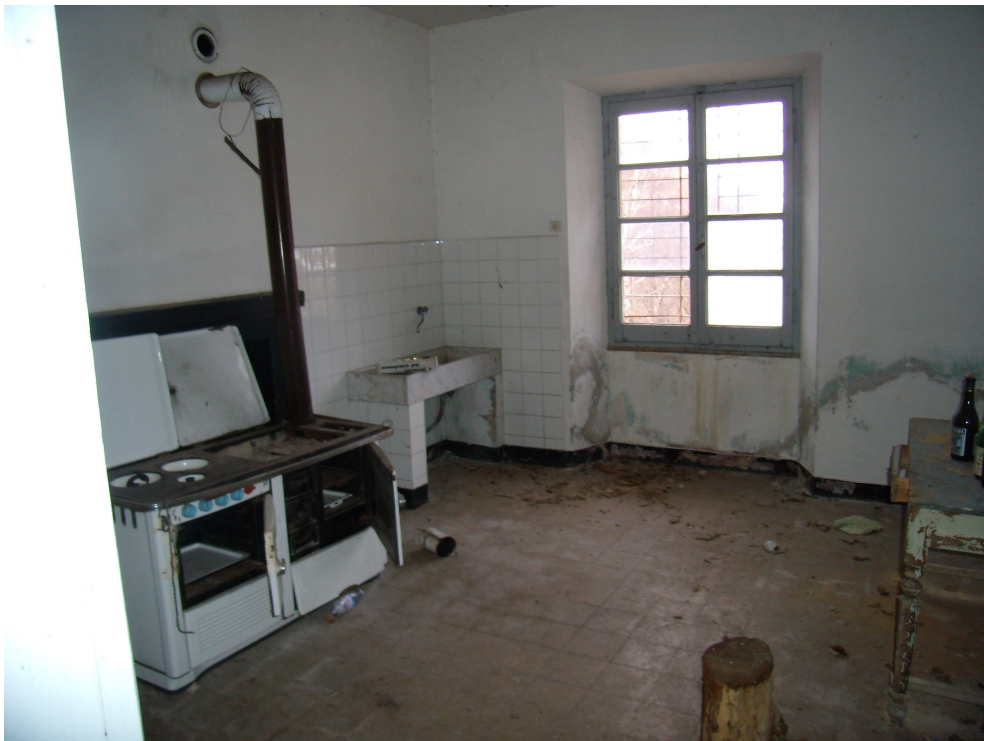
FOTO N. 4 – CASA CANTONIERA, LOCALE LATO VALLE
