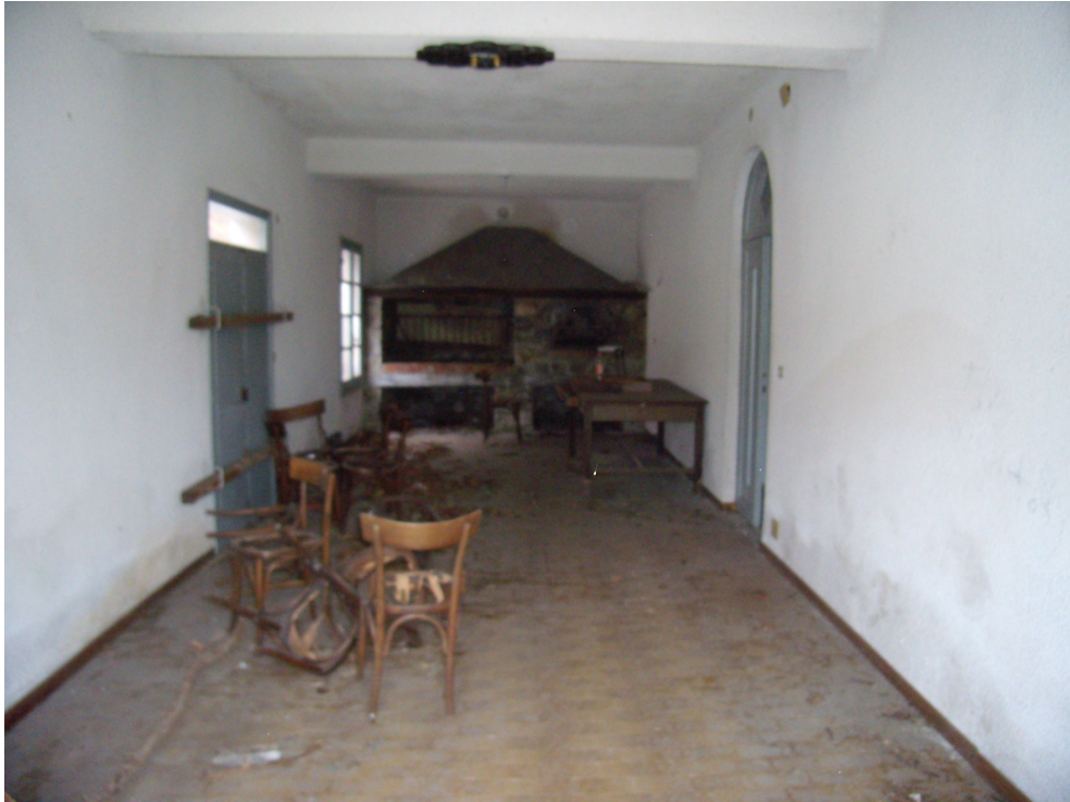
FOTO N. 3 – CASA CANTONIERA, LOCALE PIANTERRENO LATO STRADA
