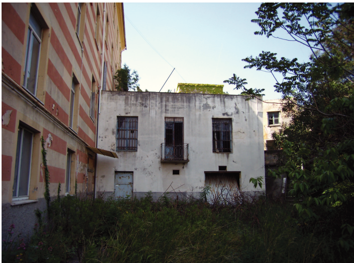
FOTO 8 – Fabbricato "C". A sinistra facciata fabbricato "A"
