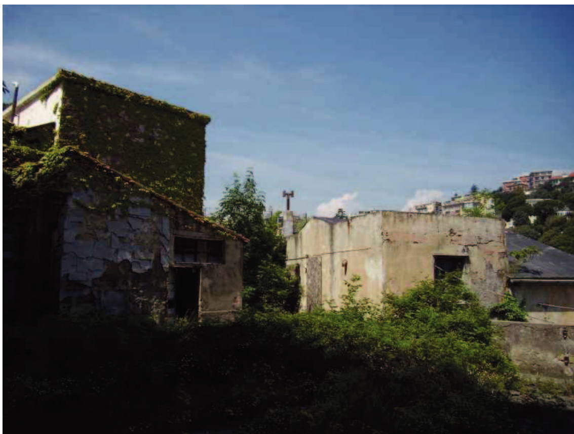
FOTO 9 – Terrazza fabbricato "C". A destra fabbricato "B" (ingresso sottotetto)
