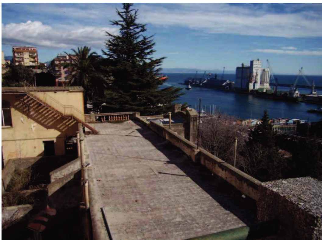
FOTO 2 – Terrazza principale fabbricato "A" e vista
