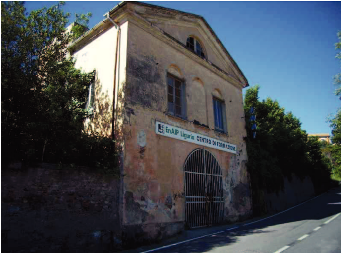
FOTO 6 – Fabbricato "B" con vecchio ingresso da via Famagosta
